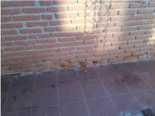
Revoque de muro
